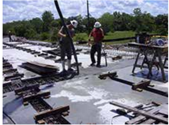
Transverse closure pour over intermediate bent.
